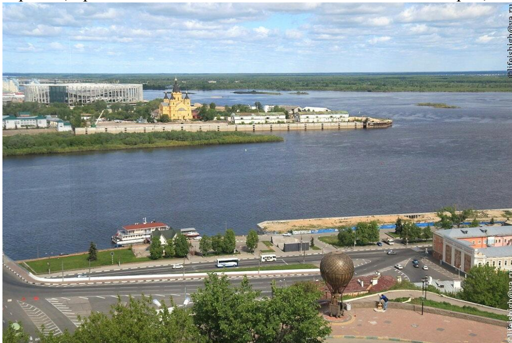
Стрелка. Стадион только строится. Зелень ещё не вырублена, но краны убрали. Фото 2017 г.
